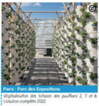
Paris - Parc des Expositions Végétalisation des toitures des pavillons 2, 3 et 6 Livraison complète 2022
