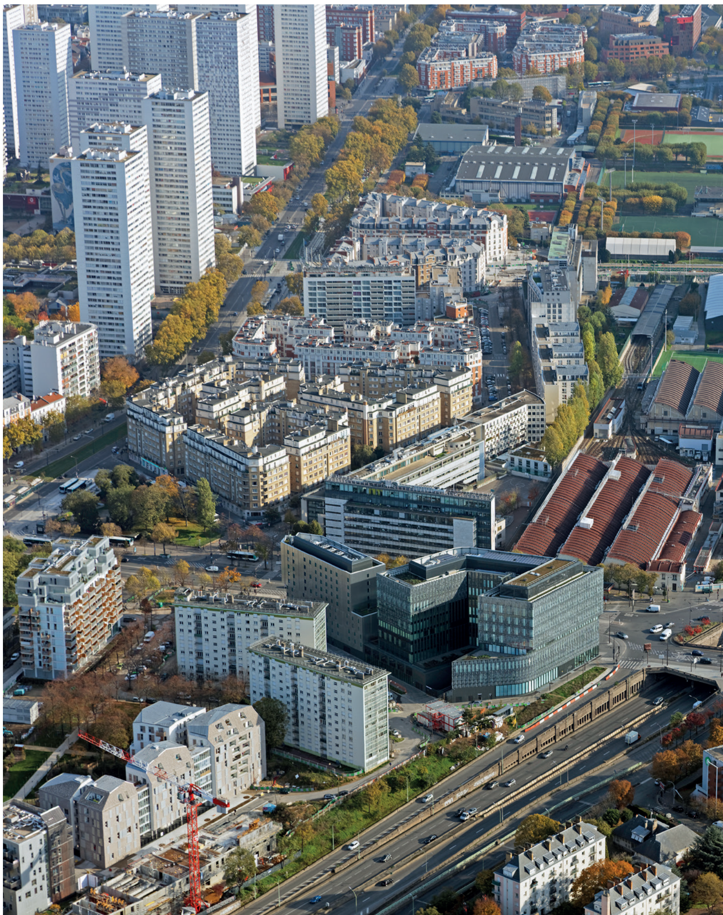
Le Boulevard périphérique secteur de la porte d'Italie - Perspective sur la porte de Choisy et la porte d'Ivry
