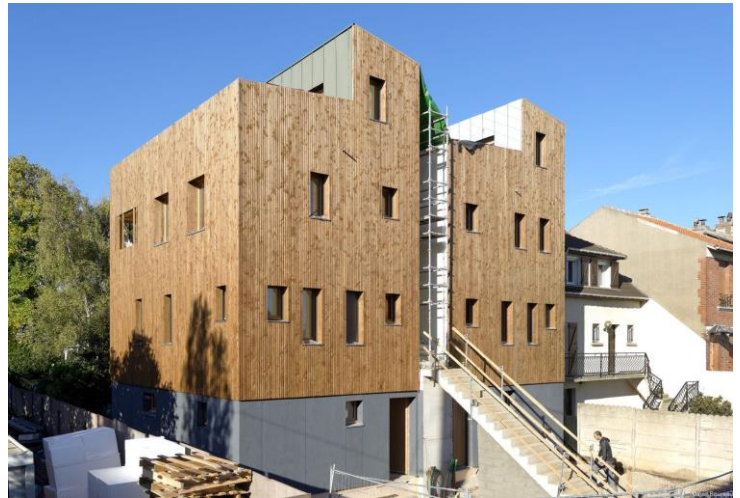
Immeuble R+2 habitat participatif situé rue du Génie à Vitry-sur-Seine par l'Atelier urbain Anne Durand © David Boureau
