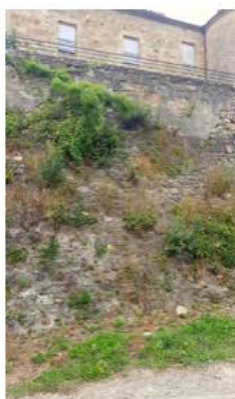
Mur de soutènement.
