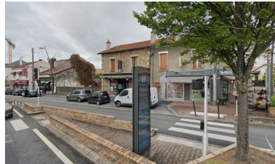
Linéaire commercial le long de la RD 25 à Savigny-sur-Orge
