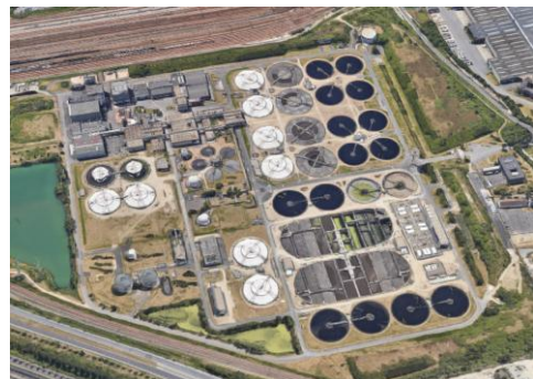
Station d'épuration Seine Amont à Valenton. Source : Source : vue Google Satellite
