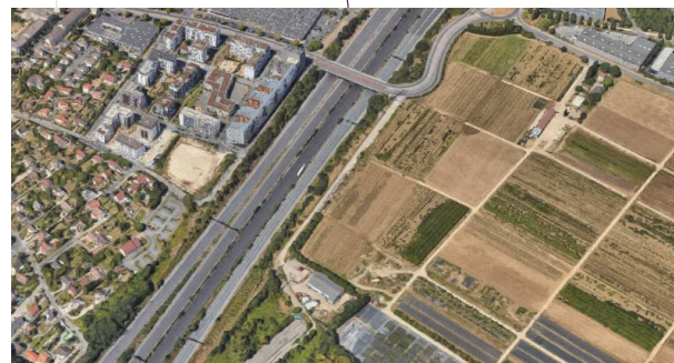
A 86 à Fresnes. Source : Google Satellite
